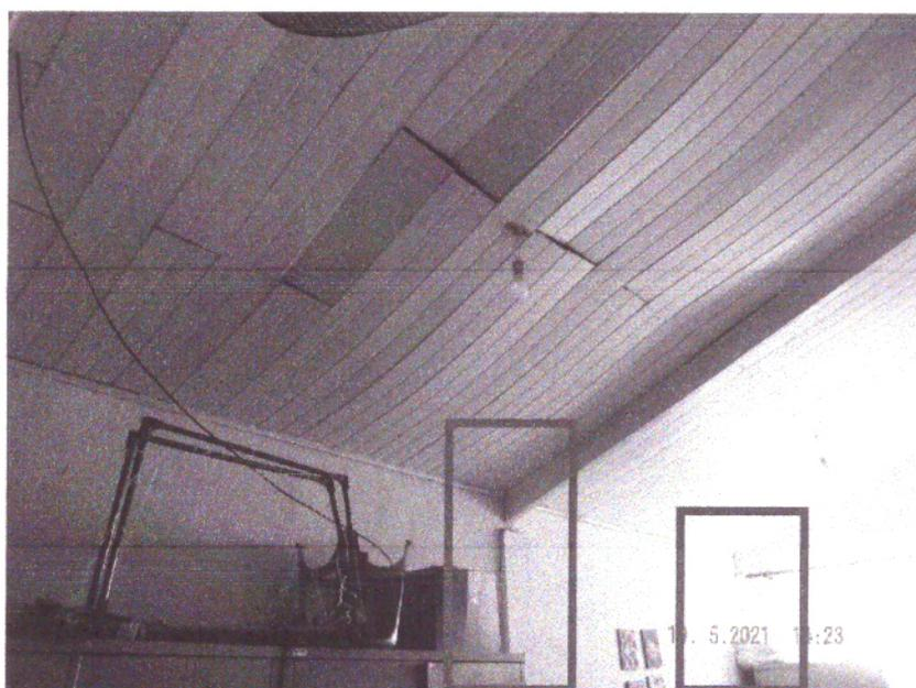
**Figura 10 - Forro PVC e Trincas – Supervisão**
